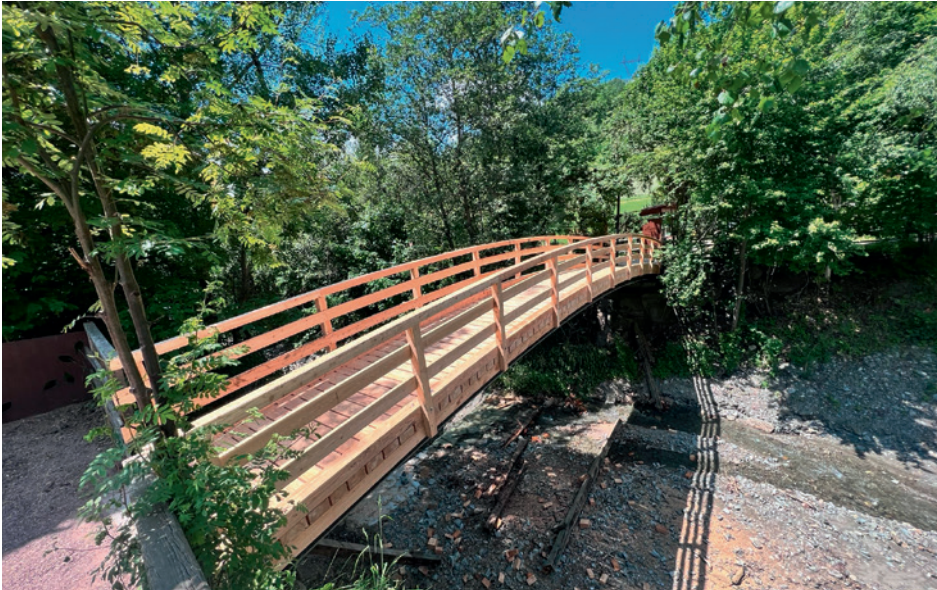
Die von den fleißigen Mitarbeitern des Gemeindebauhofes mustergültig erneuerte Fußgängerbrücke
