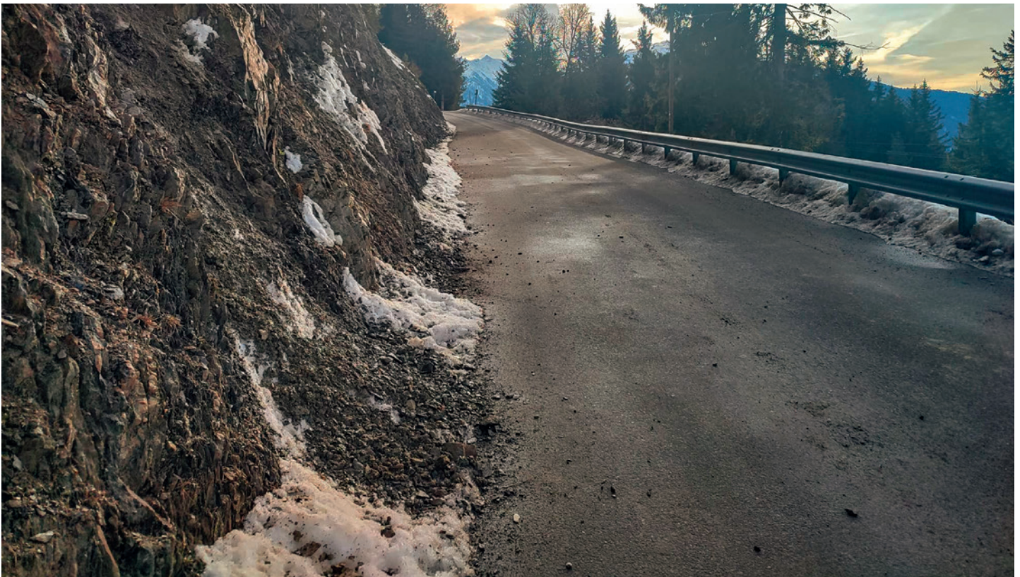
An einigen Stellen müssen die Felsen gesichert werden
