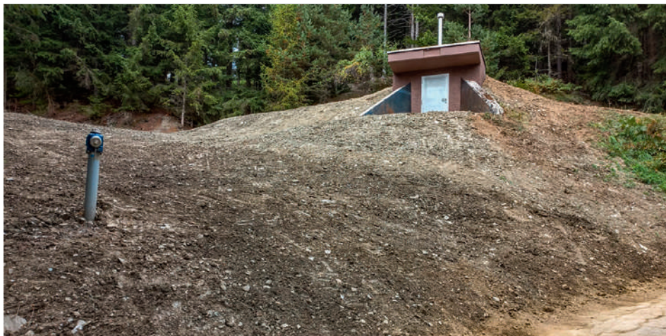
Der sanierte Trink- und Löschwasserbehälter Kreuznerberg, oberhalb des Oberhauserhofes
