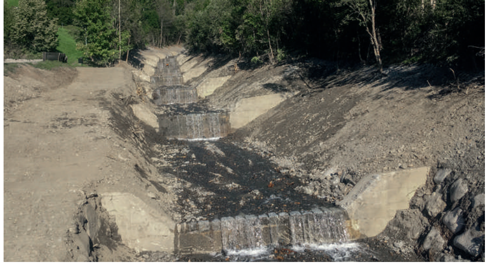
Als könnte es kein Wässerchen trüben: Der Karnergraben nach den Aufräumarbeiten, hoffentlich wieder für mindestens 100 Jahre gezähmt
