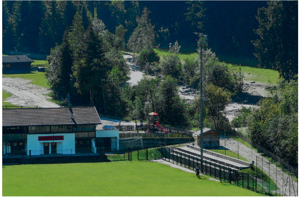
Der Fußballplatz und auch die Gebäude der Sportzone blieben von den Schlammmassen ganz knapp verschont
