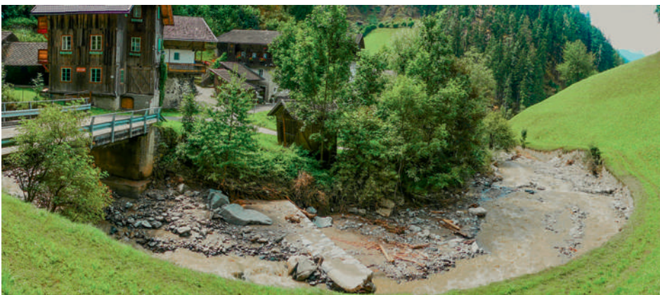
Im Weiler Kaserbach haben die Bachsperrern dem Druck der Wasser- und Geröllmassen nicht standgehalten und müssen alle neu aufgebaut werden
