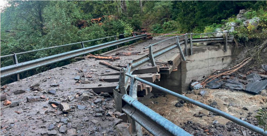
Die Brücke zum Gschlierer Hof war völlig beschädigt und wurde von den Gemeindearbeitern in Rekordzeit repariert
