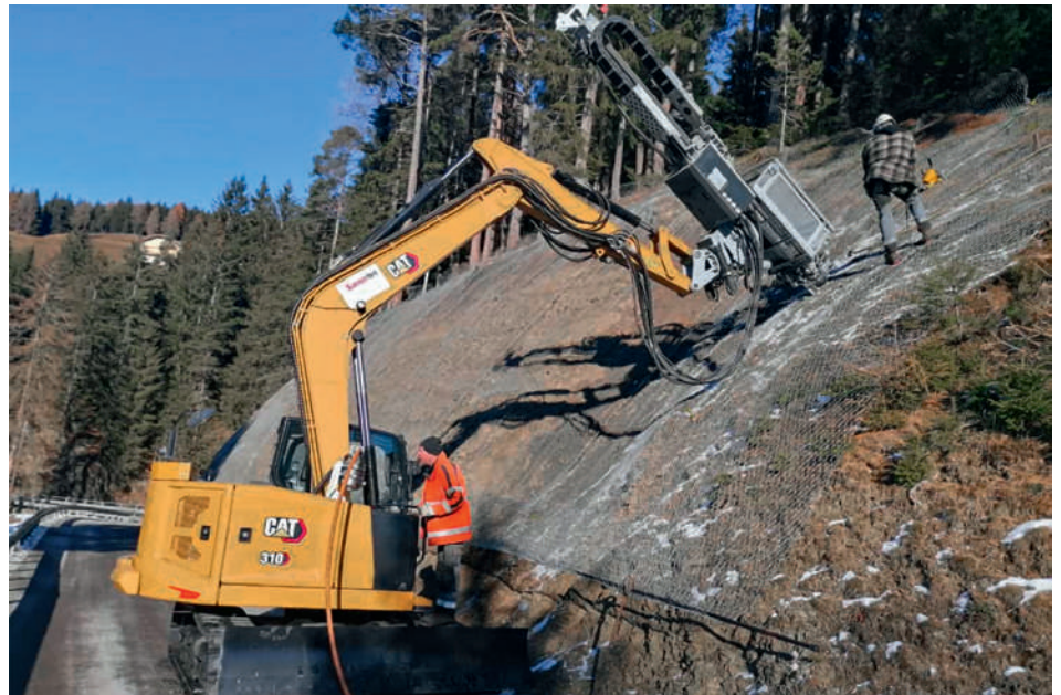
Felssicherungsarbeiten im Baulos 1 der Straße „Lüsen -Berg“ nahe Gampfoss
