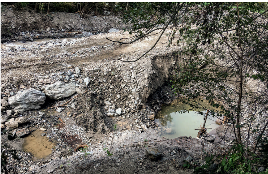
Die Wasserfassung der Beregnung in Huben war über fünf Meter hoch verschüttet
