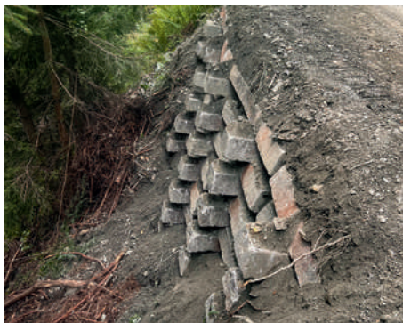
Hangsicherungsarbeiten an der Flittner Straße
